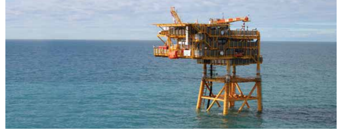
La producción de las plataformas offshore de Total Austral es tratada en las plantas de Río Cullen y de Cañadón Alfa, ubicadas en la costa de Tierra del Fuego.
