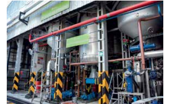
Total Especialidades Argentina cuenta con una planta de blending de lubricantes y una planta de grasas en La Tablada, con una capacidad de producción de 50.000 toneladas por año.
